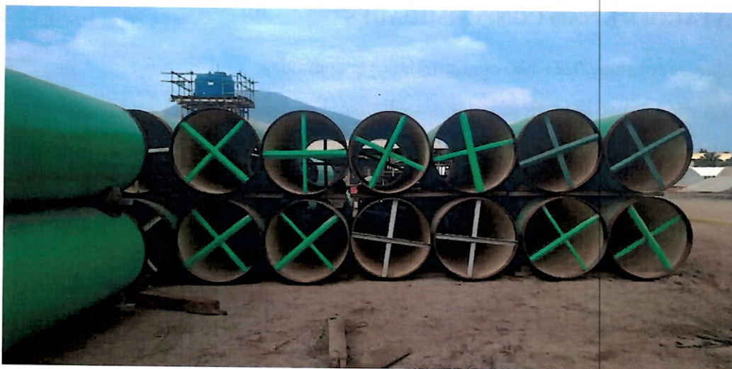
Foto 106 – Nova ETA Guandu: armazenamento de tubulações DN 1500 mm.
