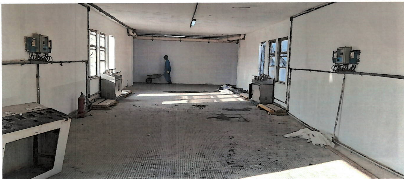
Foto 72 – Galeria de comando dos filtros em reforma.
