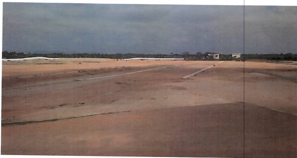
Foto 103 – Nova ETA Guandu: Obra de terraplanagem e macrodrenagem.
