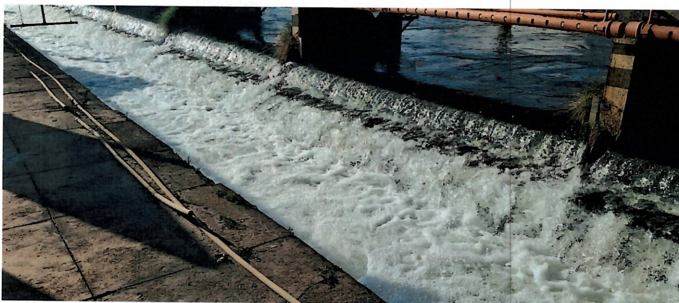
Foto 56 – Vertedouro para mistura rápida na NETA.
