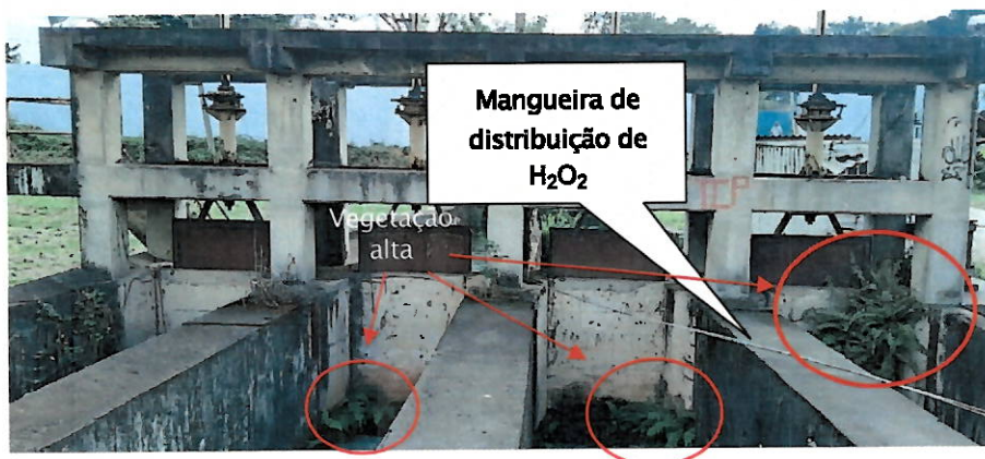
Foto 22 – Desarenadores com visualização da mangueira de distribuição de H_2O_2 e vegetação alta
