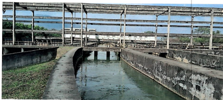
Foto 20 - Estrutura dos desarenadores de água bruta
