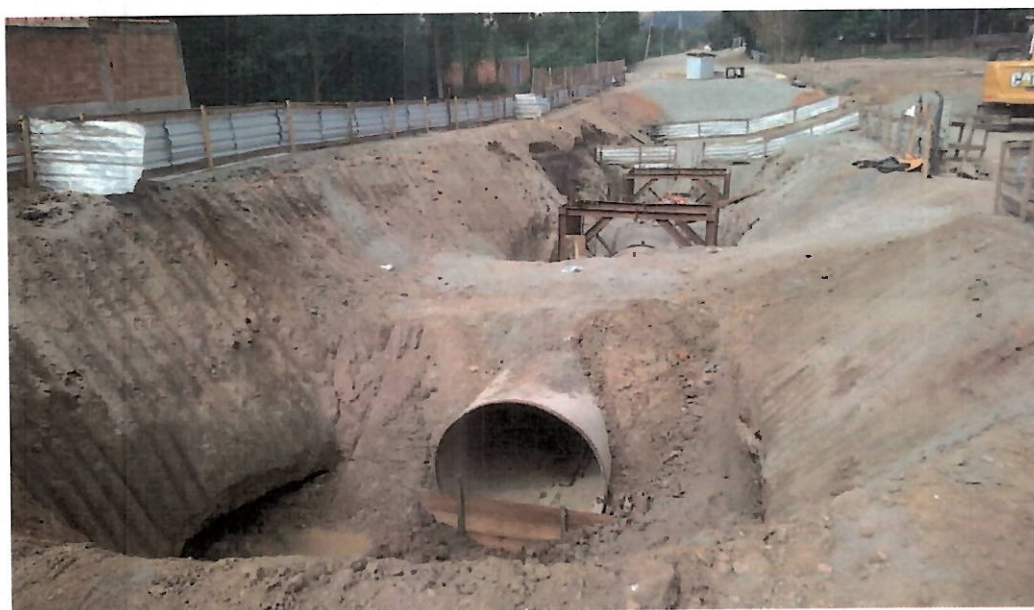
Foto 101 – Obra de assentamento de tubulação DN 2500 mm na Estrada Variante Rio-São Paulo (interligação entre Nova ETA Guandu e Novo Reservatório do Marapicu).
