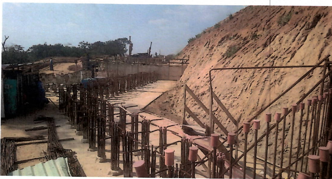
Foto 99 – Novo Marapicu: obra de terraplanagem e construção do muro de contraforte.
