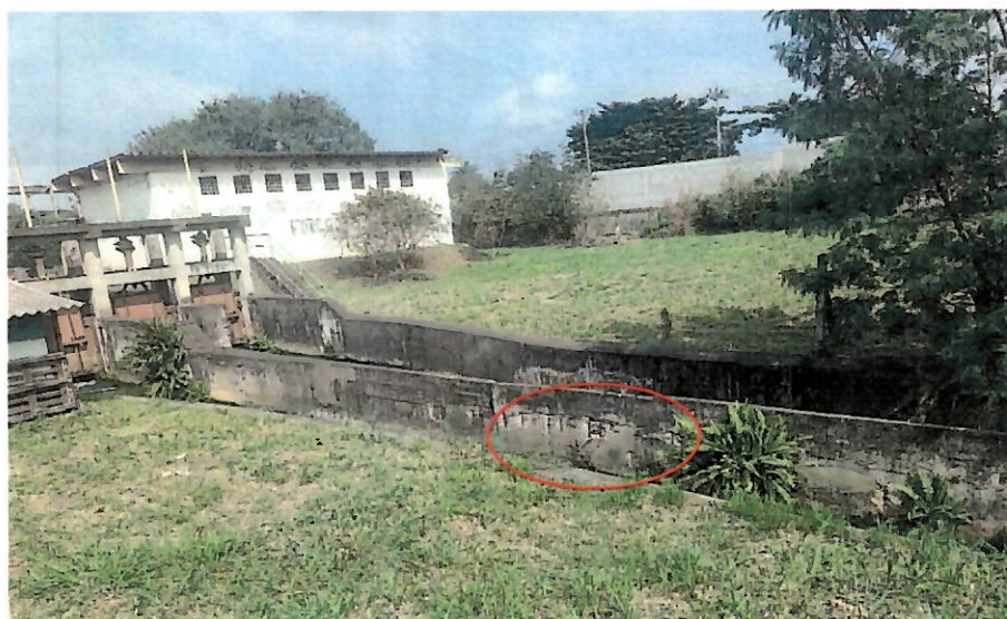
Foto 17 - Túnel de chegada da água ao desarenador
