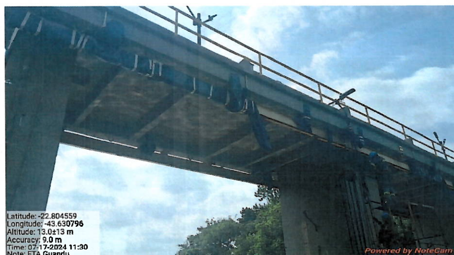
Foto 5 - Revitalização das estruturas em andamento.
