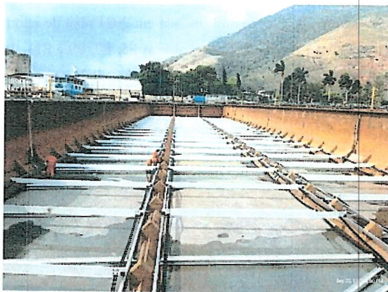
Foto 49 – Finalização da obra do novo sistema de retirada de lodo (Foto retirada de relatório fotográfico de acompanhamento de obra de 2023).
