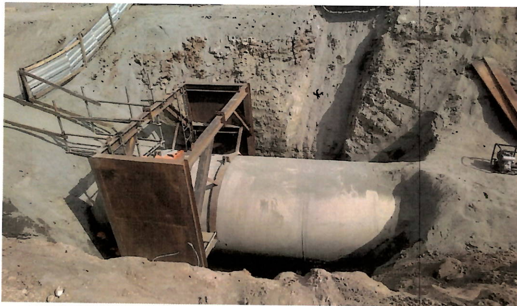
Foto 102 – Obra de assentamento de tubulação DN 2500 mm na Estrada Variante Rio-São Paulo (interligação entre Nova ETA Guandu e Novo Reservatório do Marapicu).
