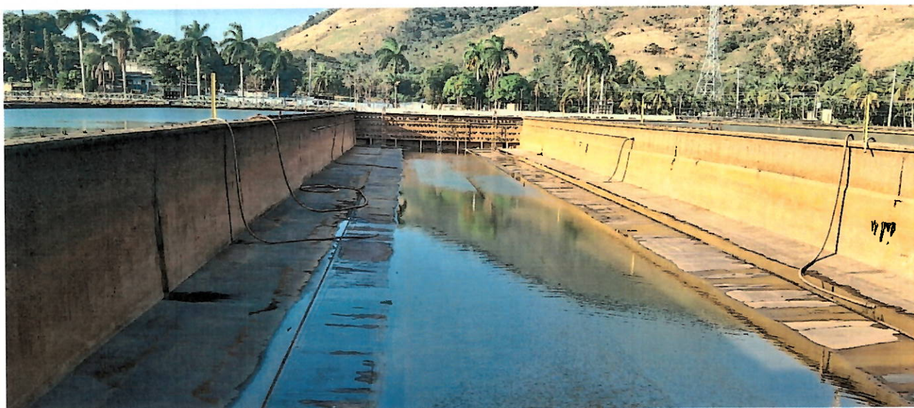
Foto 48 – Vista do Decantador 3 que estava em processo final de limpeza.
