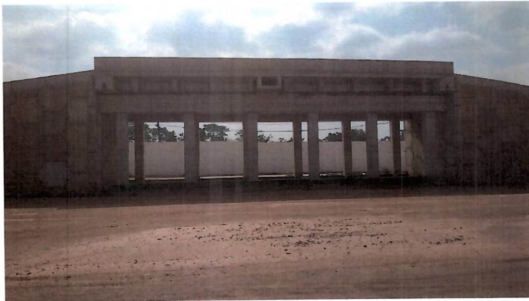
Foto 104 – Nova ETA Guandu: viaduto construído para aplicação de produtos químicos.
