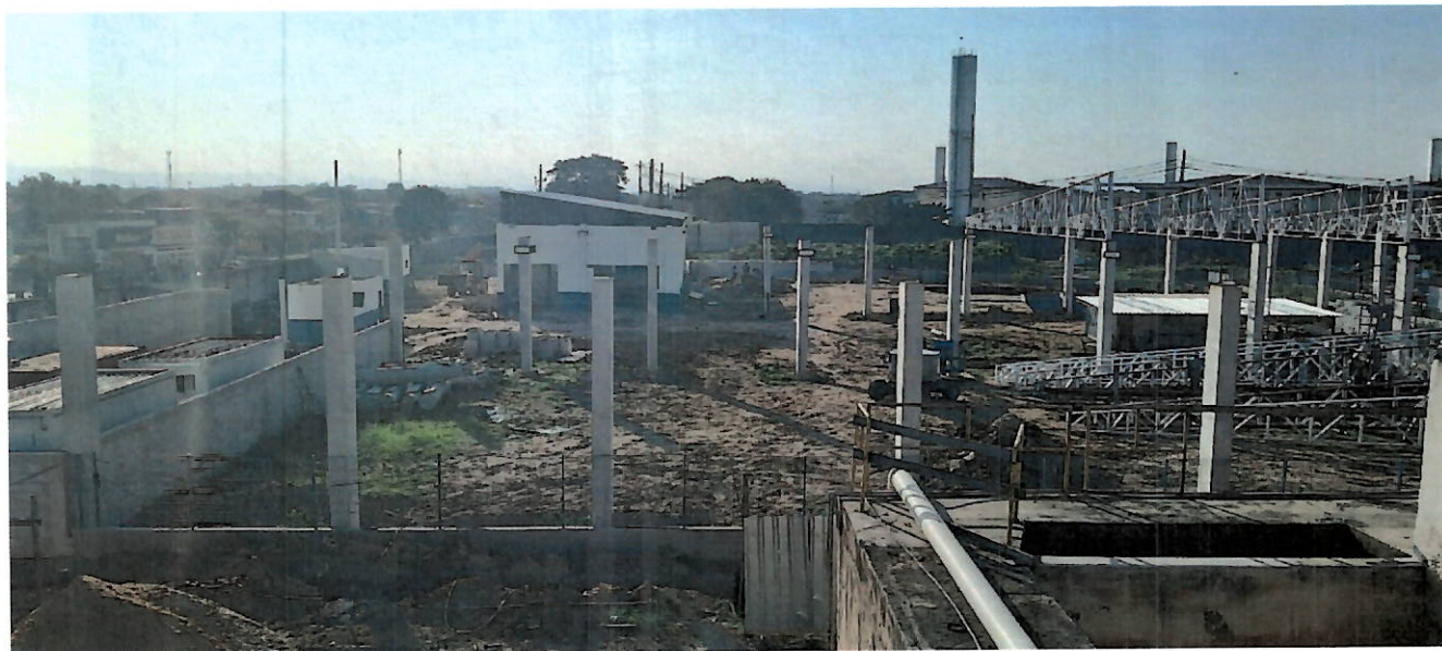
Foto 97 – Área onde está sendo construída unidade para otimização da disposição do lodo gerado na estação.
