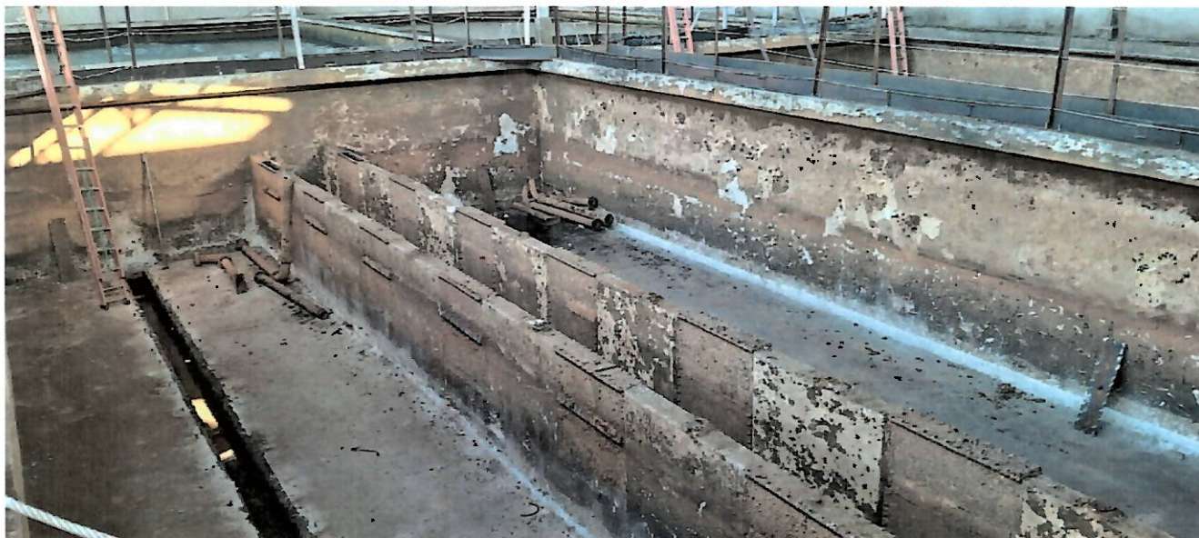
Foto 52 – Filtro em preparação para reforma.
