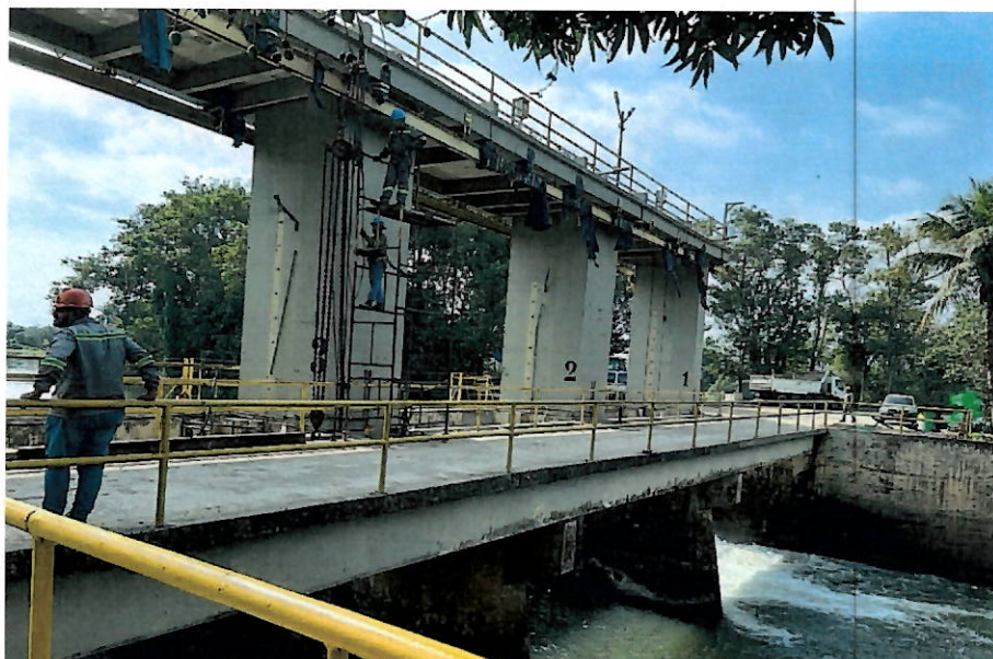
Foto 3 - Barragem auxiliar com visualização das três comportas.
