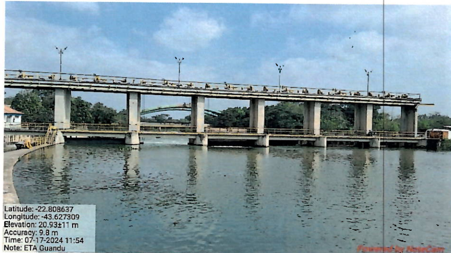
Foto 6 - Barragem principal na captação de água do Rio Guandu
