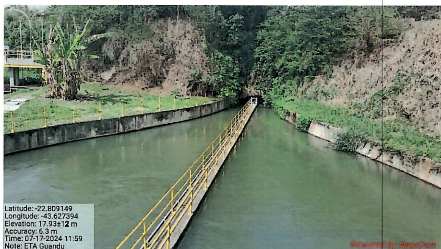
Foto 14 - Entrada do túnel canal
