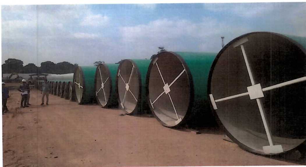
Foto 105 – Nova ETA Guandu: armazenamento de tubulações DN 2500 mm.
