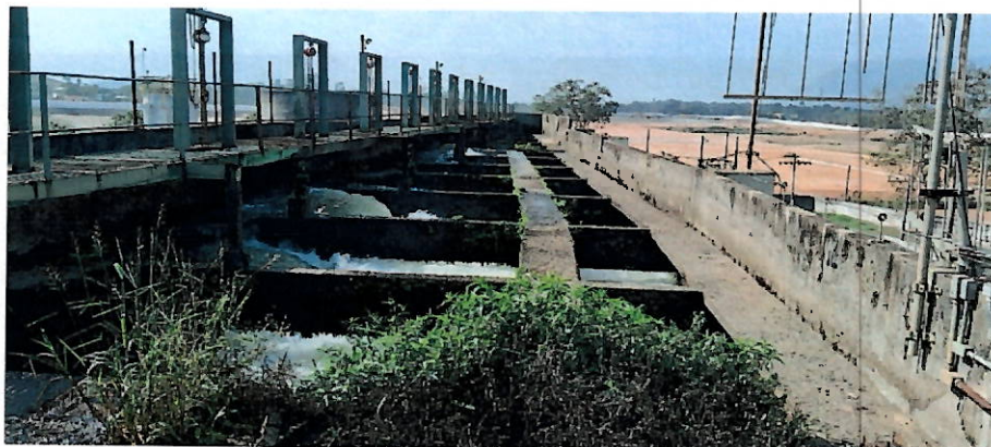
Foto 30 – Reservatório de água bruta localização acima do BRG
