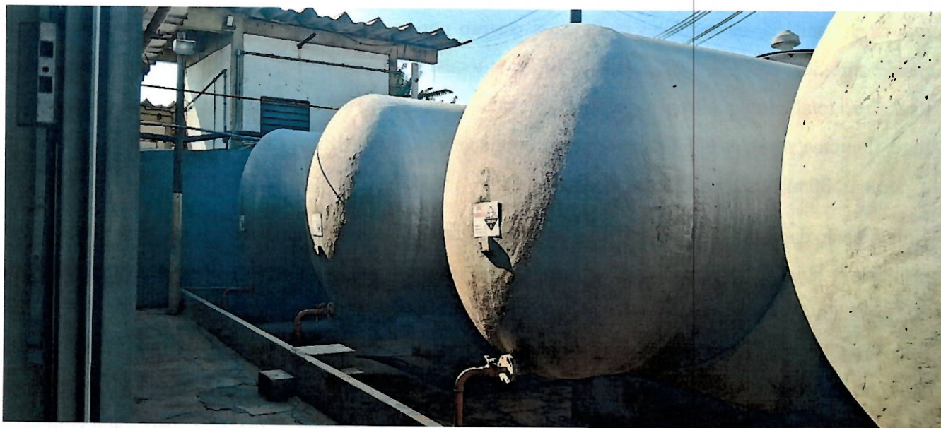
Foto 87 – Reservatórios de ácido fluossilícico.
