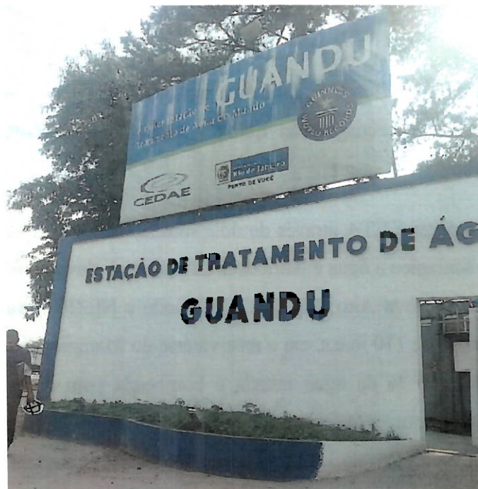
Foto 1 - Entrada da Estação de Tratamento de Água Guandu
