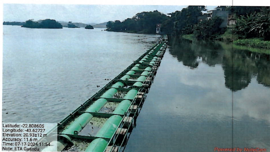
Foto 11 - Localização da barragem flutuante de contenção de sólidos grosseiros
